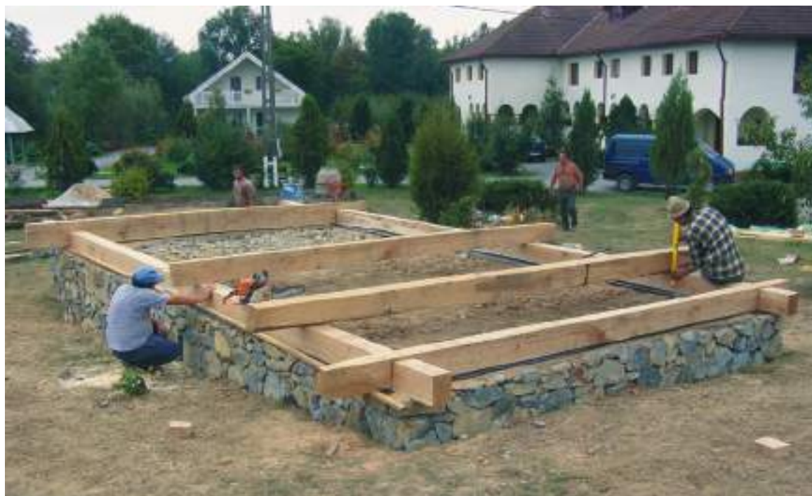
Pentru a proteja lemnul dintre soclu și tălpi s-a pus un strat de carton asfaltat
