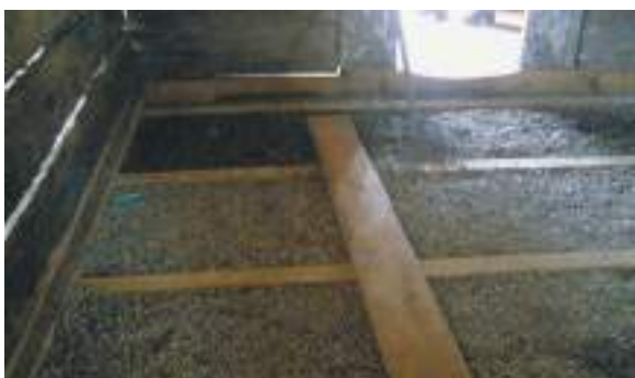
După ce pietrișul a fost nivelat, dușumelele sunt poziționate în interior spre tăiere
