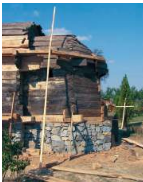
Vedere cu sistemul de acoperire de peste altar
