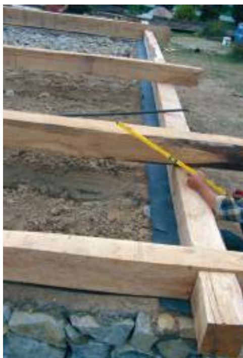
Pentru a proteja lemnul dintre soclu și tălpi s-a pus un strat de carton asfaltat
