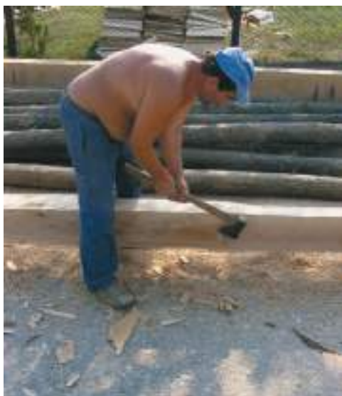
O bărnă din lemn de stejar, cu o lungime 9 m, avea o greutate de aproximativ 300 kg
