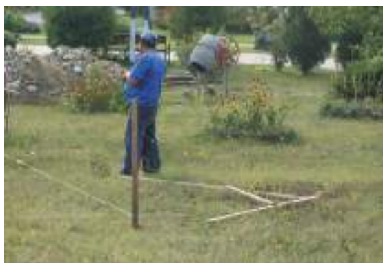
În timpul trasării s-a folosit un vinclu de lemn pentru măsurarea unghiurilor
