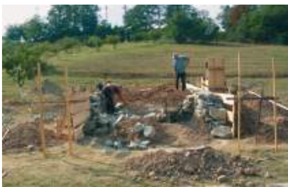
15 septembrie 2009, s-a început umplerea cu pământ a spațiului dintre elevații
