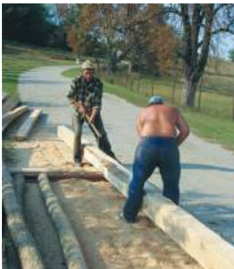
Ștefan și Ion au cioplit tăpile noi, pentru a le așeza pe soclu.
