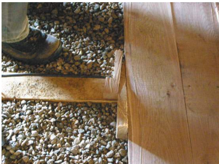
La montarea dușumelei s-au folosit clești și pane pentru fixare
