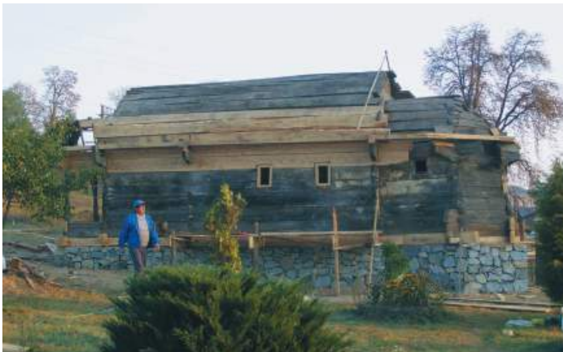
24 septembrie 2009, fațada sud cu cele două sisteme geometrice diferite de închidere a spațiului interior
