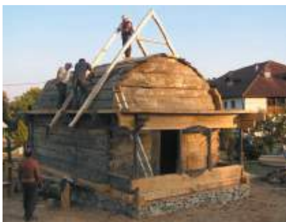
Fațada vest în timpul montării căpriorilor
