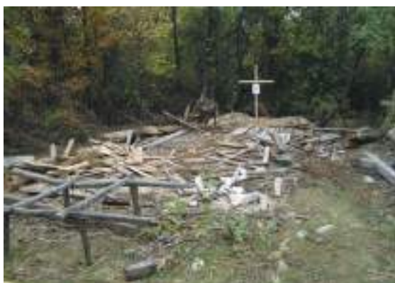
Imediat după demontarea bisericii, o cruce de lemn se așează în zona altarului până în momentul curățării locului și a montării unei troițe comemorative
