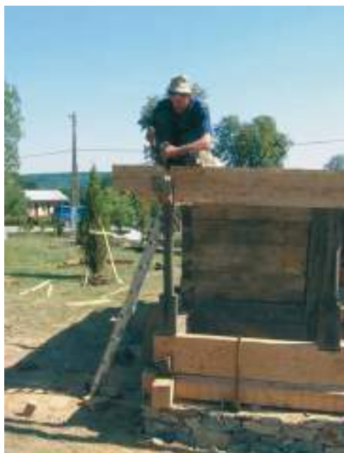
Ion a făcut mici ajustări înaintea punerii bânelor de susținere a căpriorilor
