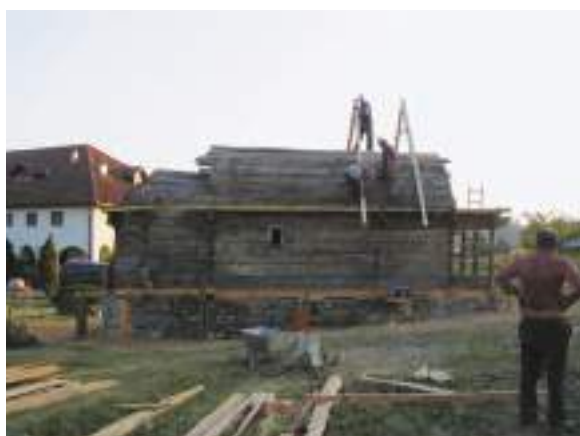
Fațada nord în timpul montării căpriorilor
