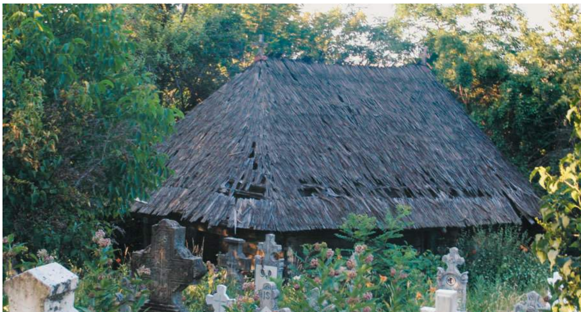
Ultima fotografie înaintea începerii lucrărilor
