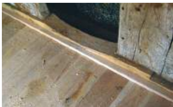
S-au montat pervazele pe conturul interior al încăperii
