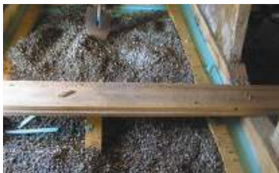
Peste termoizolație s-a venit cu un strat de pietriș
