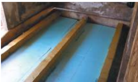
După poziționarea cușacilor, s-a așezat termoizolația
