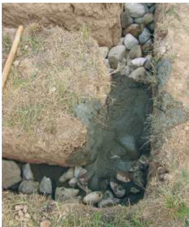
Fundația s-a executat din beton ciclopian până la 25 cm sub cota terenului sistematizat.
