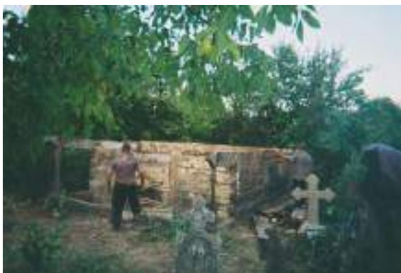
Meșterii numerează bârnele înaintea demontării lor
