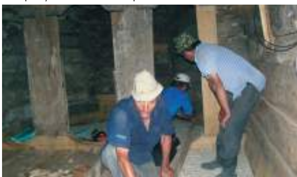
Ion, Gheorghe și Mihai au lucrat la montarea dușumelei în naos
