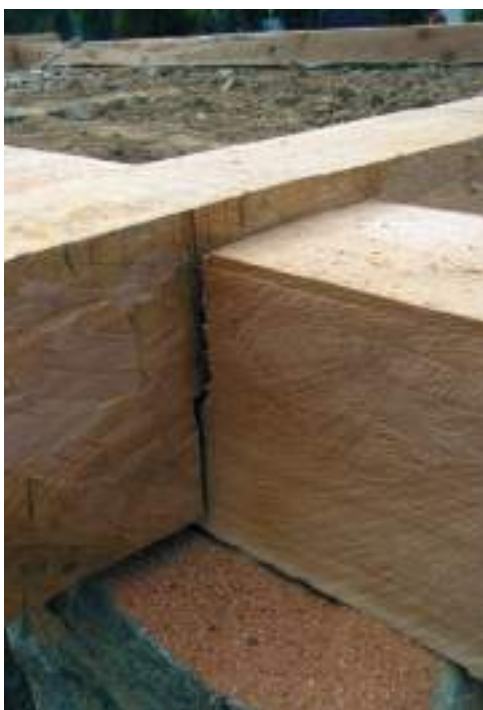
La îmbinarea tălpilor s-a utilizat o îmbinare simplă
