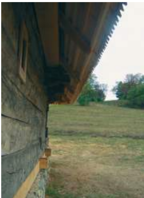
Detaliu din fațada de nord
