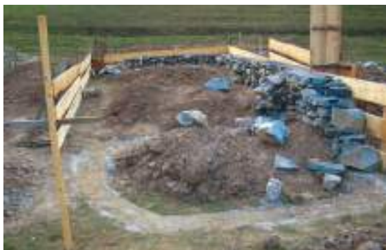
11 septembrie 2009, s-a pregătit cofrajul pentru începerea execuției elevației de piatră
