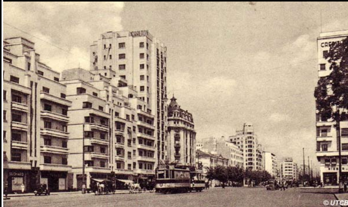
Fig. 1. Blocul Carlton înainte de cutremurul din noiembrie 1940
