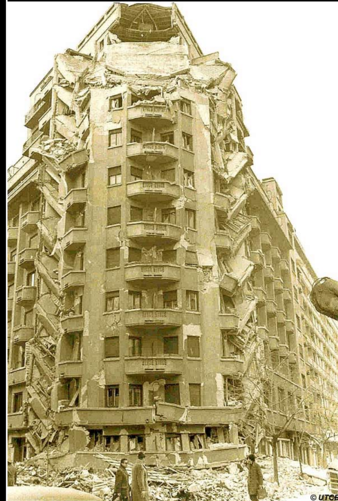
Fig. 3. 4 Martie 1977 Blocul Wilson
