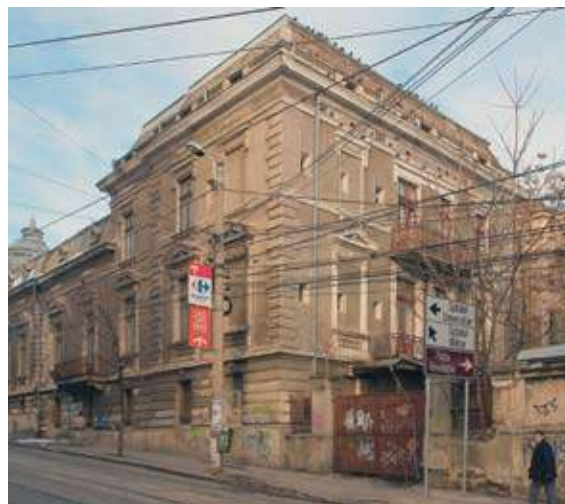
Ansamblu de arhitectură str. Știrbei Vodă nr. 89 – monument istoric, cod LMI B-II-m-B-19760, demolat
