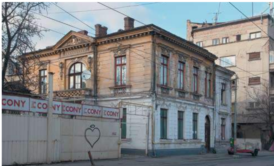
Casă str. Berzei nr. 81 – monument istoric, cod LMI B-II-m-B-18142, demolat
