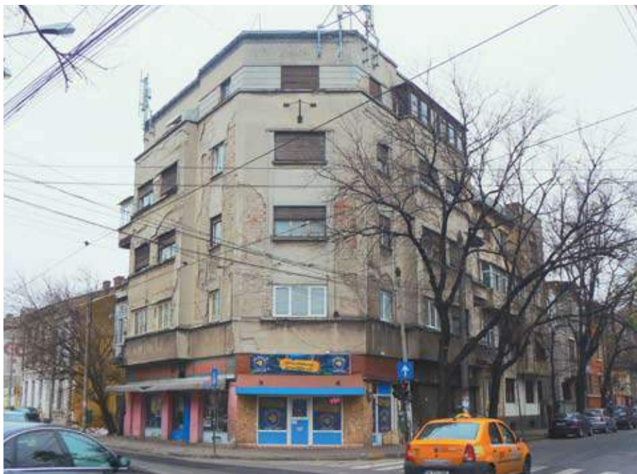
Blocul Prager, str. Mircea Vulcănescu nr. 87, demolat
