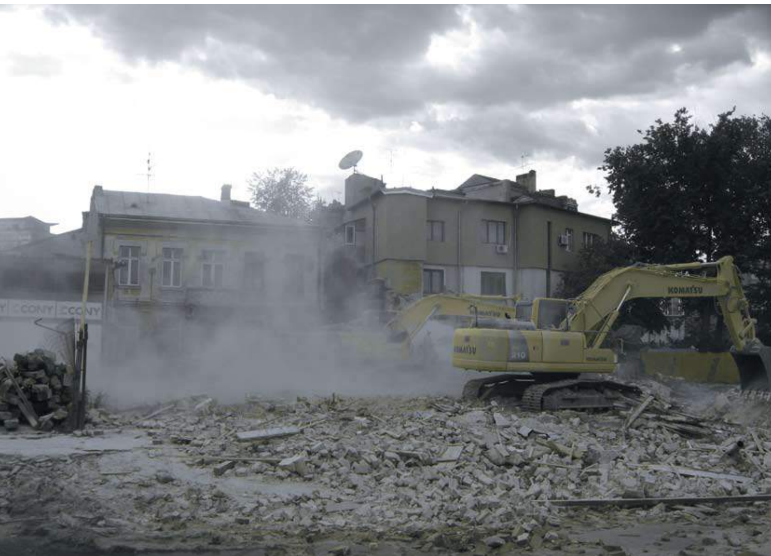
Cum se lucrează pe șantier (iulie 2011)
