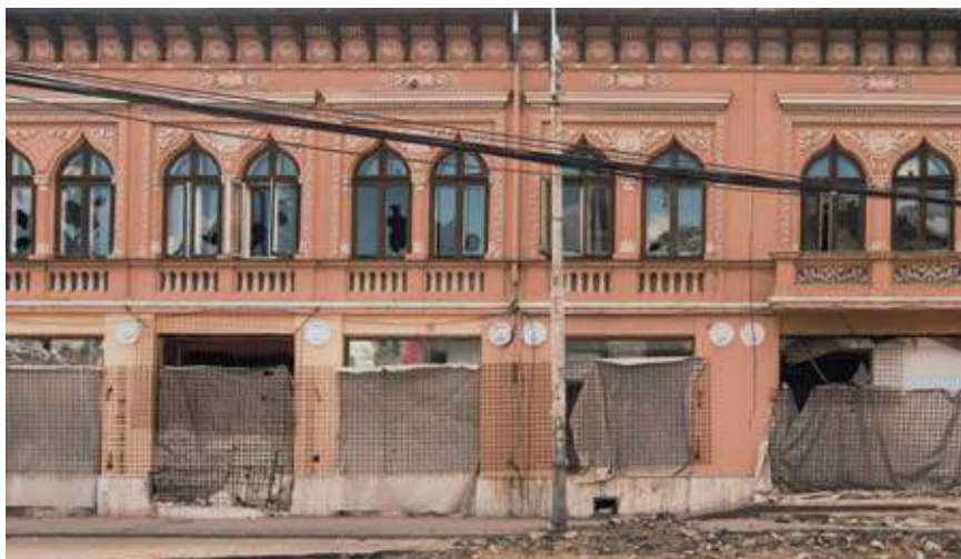
Fațadă principală, clădirea din piața Haralamb Botescu nr. 18, iulie 2011
