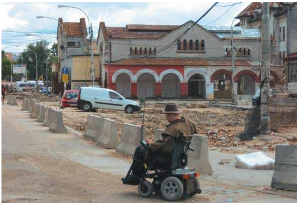
Strada Berzei în șantier, iulie 2011
