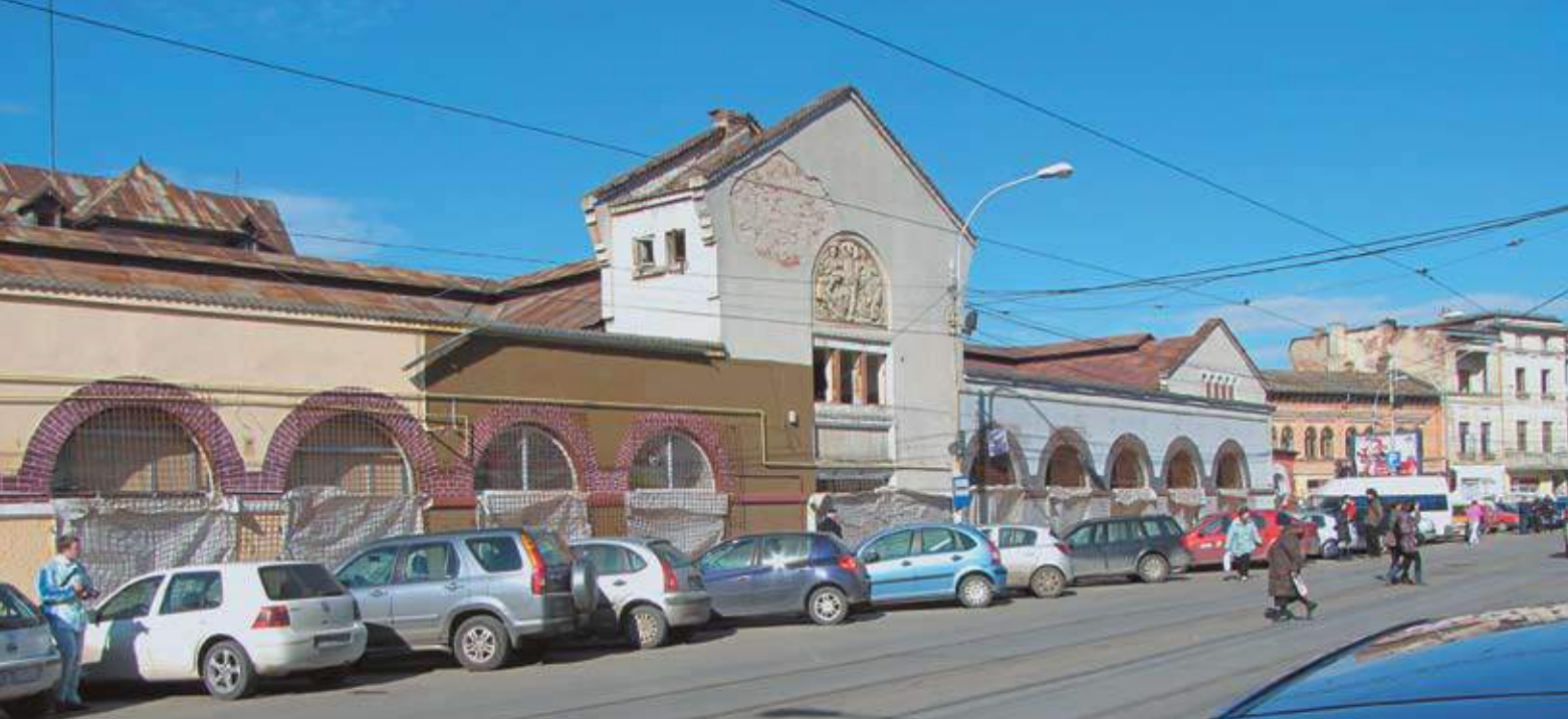
Strada Berzei – februarie 2011
