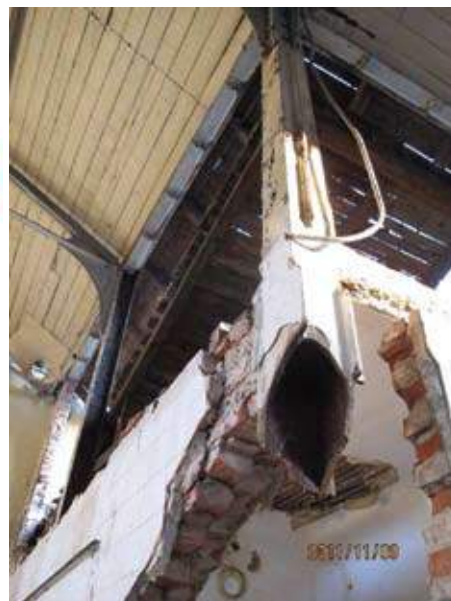
Detaliu spargere stâlpi metalici de susținere, noiembrie 2011
