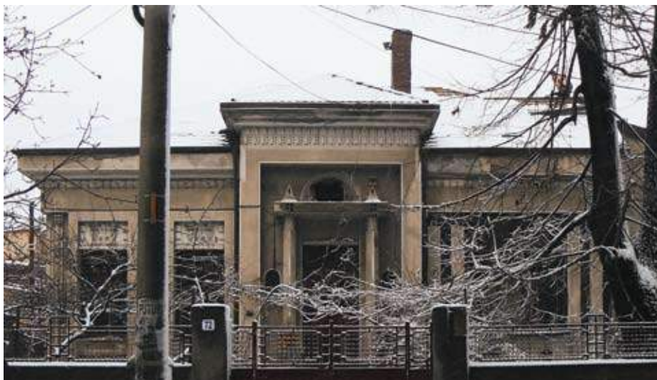
Casă, str. Mircea Vulcănescu nr. 72, demolată
