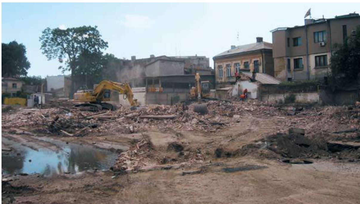
Strada Berzei în șantier, iulie 2011
