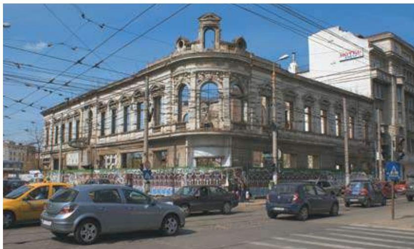
Casa Rădulescu (fostă Matache Măcelaru, fostă Cinema Feroviarul) – monument istoric, cod LMI B-II-m-B-18876, demolat
