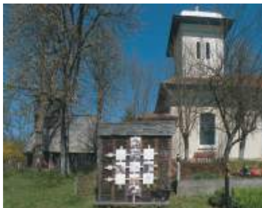
Panou de informare realizat de studenți voluntari în 2012, care au supravegheat lucrarea de reparație a învelitorii.
