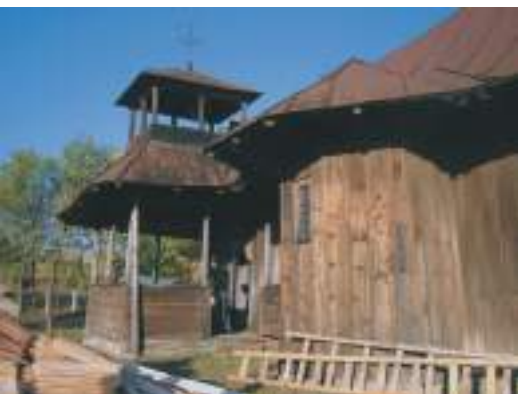
Biserica înainte de reparații
