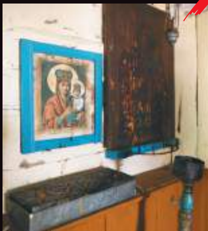
Lumânărar așezat sub icoană și în vecinătatea imediată a peretelui de lemn. Pictura de pe icoană este înnegrită de fum și deteriorată de căldură. Amplasarea lumânărilor poate, de asemenea, provoca un incendiu.
