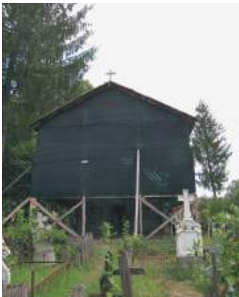
Lucrări de conservare: structură de protecție și sprijiniri la biserica de lemn din satul Urși, județul Vâlcea
