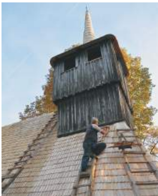
Lucrări de reparație la învelitoarea de șită a bisericii de lemn din satul Tărnăvița, județul Hunedoara (foto 2012)
