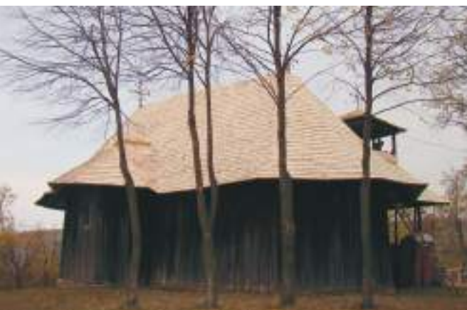
Biserica după reparații și înlocuirea tablei cu șită
