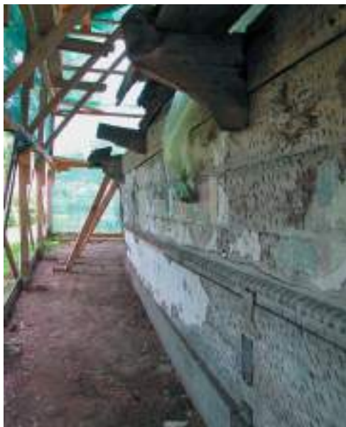
Lucrări de conservare: structură de protecție și sprijiniri la biserica de lemn din satul Urși, județul Vâlcea
