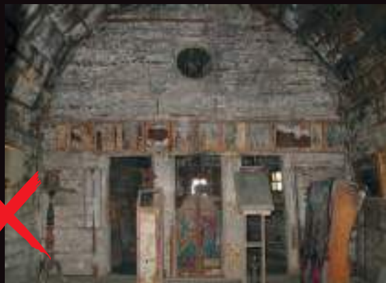
Pictură al secco care se desprinde de pe suport din cauza umidității persistente.
