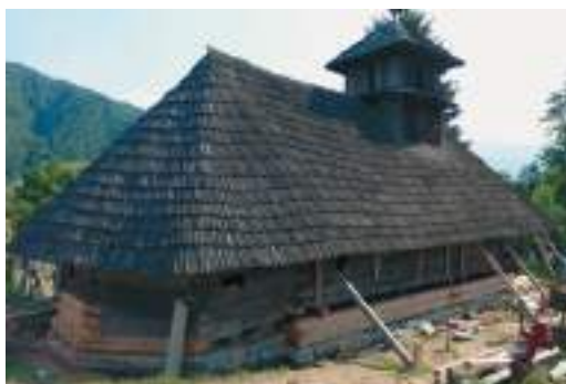
Exemplu de înlocuire a tălpilor de lemn deteriorate cu bârne noi, pe fundație din piatră. Sus: detaliu, jos: imagine de ansamblu
