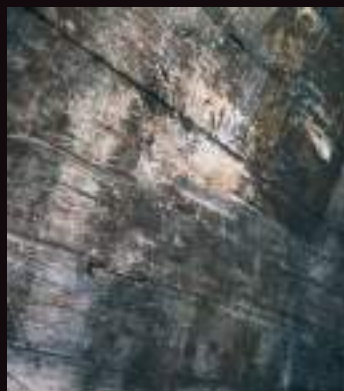
Exemplu de pictură zgâriată de posibile încercări de curățare sau de vandalism.
