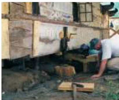
Ridicarea bisericii pentru înlocuirea tălpilor de lemn și realizarea fundațiilor din piatră, 2013.
