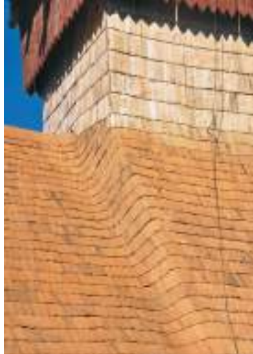
Paratrăsnet montat pe învelitoarea de șită; este sistemul cel mai des întâlnit. Punctele de fixare trebuie să fie izolate, astfel încât la supraîncălzire să nu provoace arderea lemnului. Punctele de prindere pe șita sunt însă puncte vulnerabile unde șita se deteriorează mai repede.
