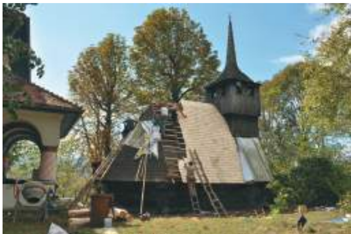
Lucrări de reparație la învelitoarea de șită a bisericii de lemn din satul Tărnăvița, județul Hunedoara (foto 2012)
