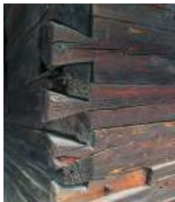
Bârne orizontale de lemn îmbinate la capete cu chertări de tip „coadă de rândunică”
