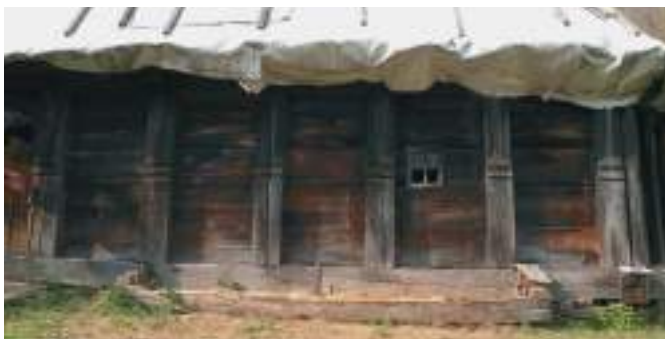
Stâlpi fixați cu cep într-o talpă orizontală și o grindă superioară. Pereții sunt din dulapi de lemn fixați între stâlpi.
