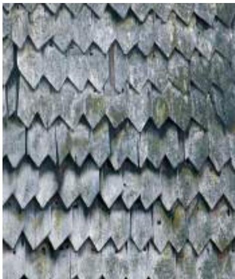
Detalii de șiță degradată în timp
