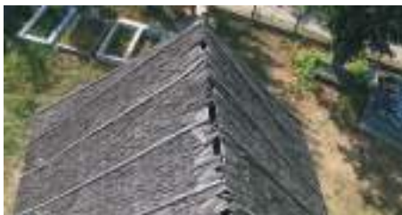
Detalii de șiță degradată în timp
