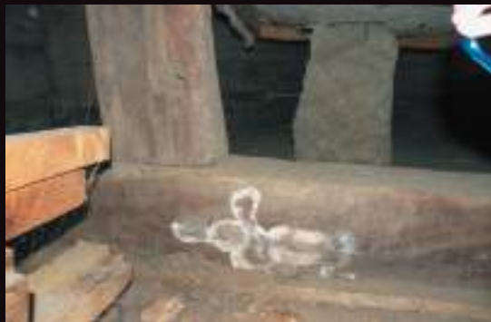
Degradări biologice ale lemnului în zonele cu umiditate crescută (ciuperci ce cauzează putrezirea).
