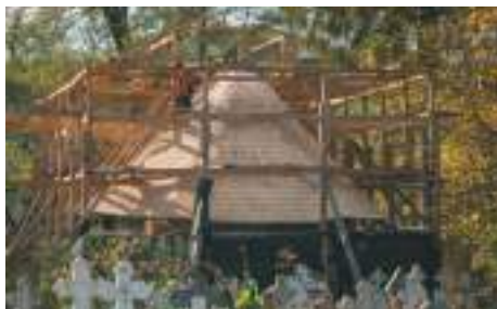
Refacerea acoperișului și a învelitorii de șită, 2015.
