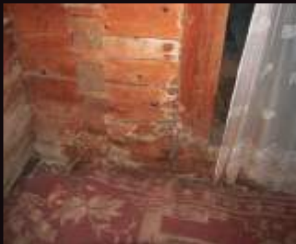
Degradări biologice ale lemnului în zonele cu umiditate crescută (ciuperci ce cauzează putrezirea).
