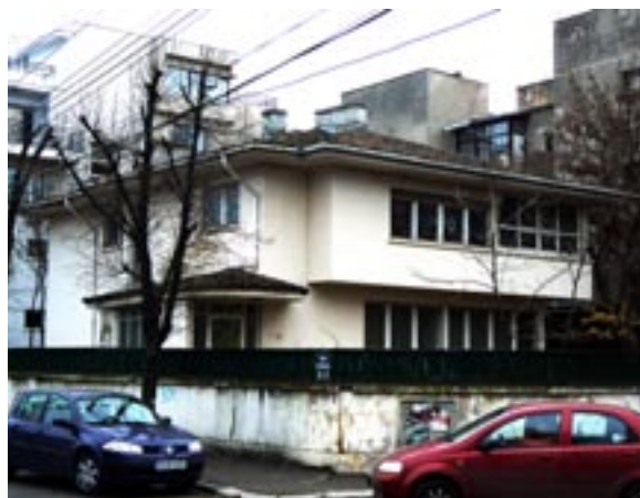
Imobilul din Bd. Aviatorilor nr. 92, înainte de demolare
