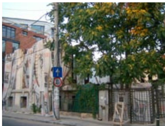
Imobilul din strada Visarion nr. 8, înainte și după demolare
