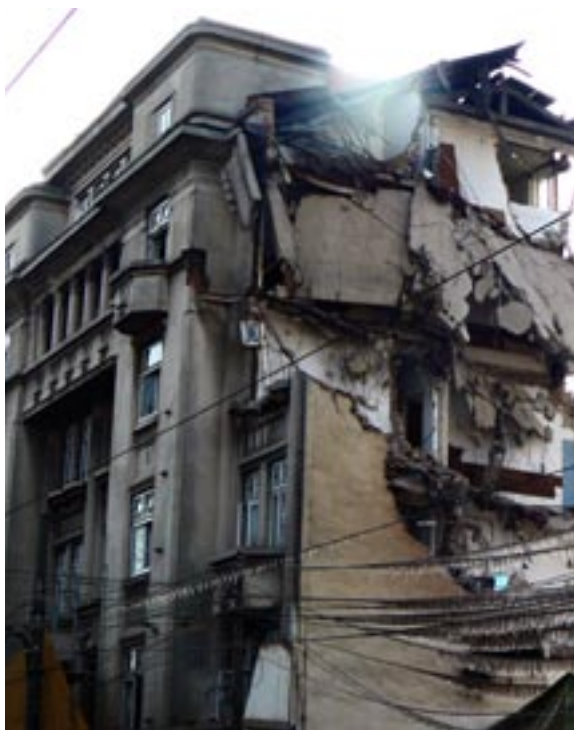
Fostul hotel Marna, în timpul demolării; str. Buzești nr. 6
