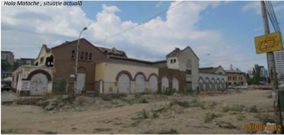
Hala Matache , situație actuală
