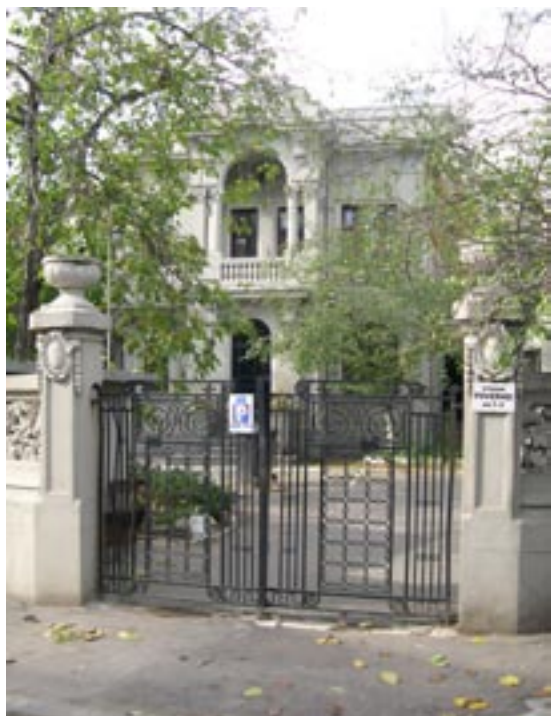
Fostul imobil din strada Povernei nr. 1-3, înainte și în timpul demolării
