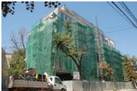
Aleea Alexandru nr. 28, clădire nouă în locul celei demolate
